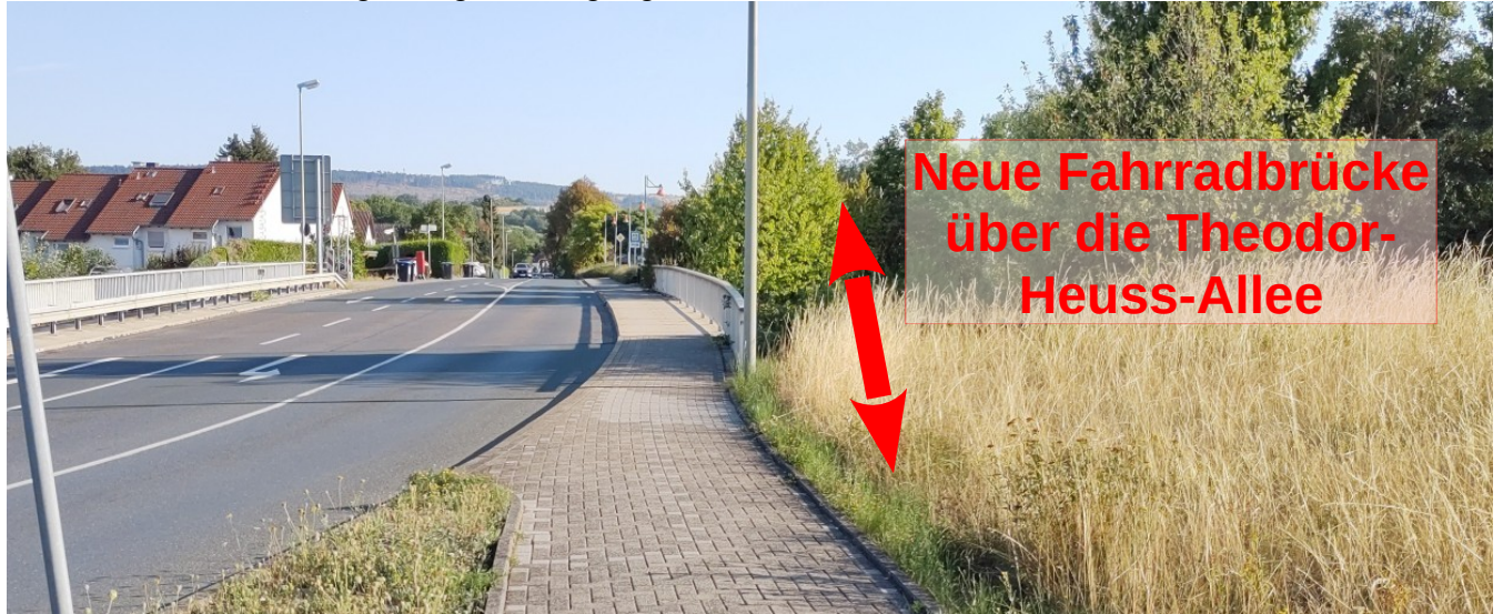
Bild 3: Vorhandener Bürgersteig für Fußgänger, rechts daneben eine neue Brücke für den Radverkehr
