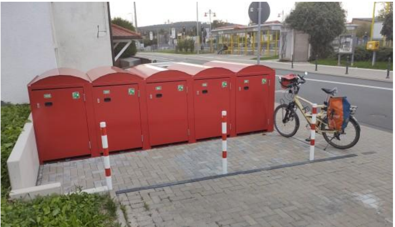
Bild 1: neue Fahrradboxen - zu wenig Platz und Türen mit falschem Seitenanschlag; Verortung in Open Street Map
