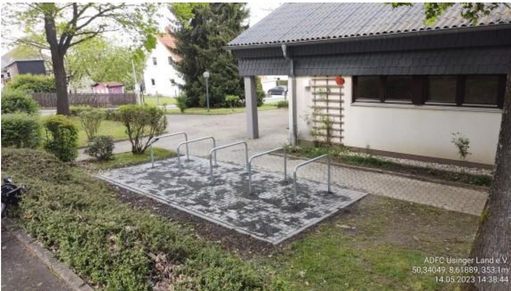
Bild 01: Neue Fahrradbügel ohne Überdachung an der Holzbachhalle in Friedrichsthal; Verortung in Open Street Map
